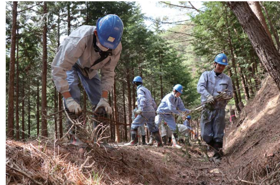
側溝を埋めてしまった土砂や枯れ木を撤去する林道整備（写真左）。 管理する人手がないために生い茂って道をふさいでいた竹を伐採します（写真右上）。 竹林整備をいっしょに手伝ってくれた地元の小学生たちと（写真右下）。
